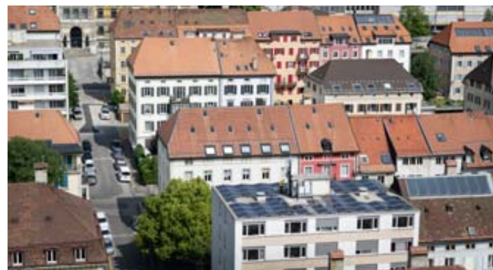
Des panneaux solaires ont déjà fleuri sur les toits de la ville. LUCAS VUITEL
